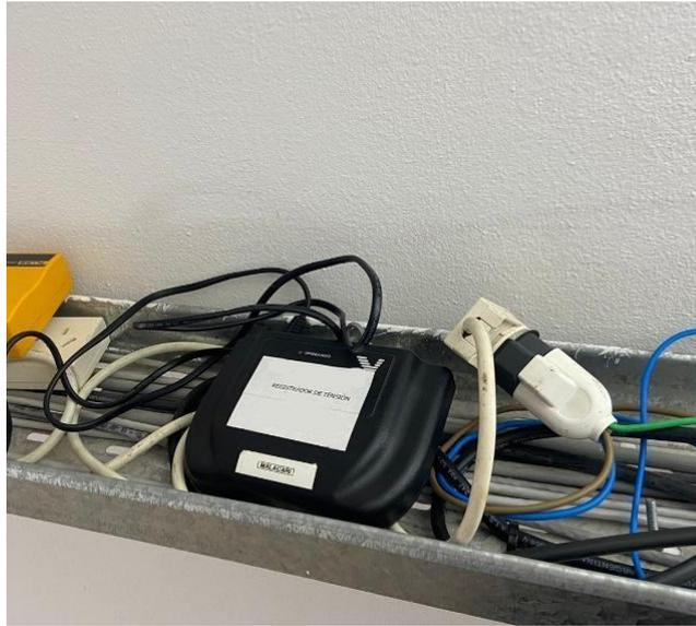
**Figura 21. Registrador instalado en bandeja.**
