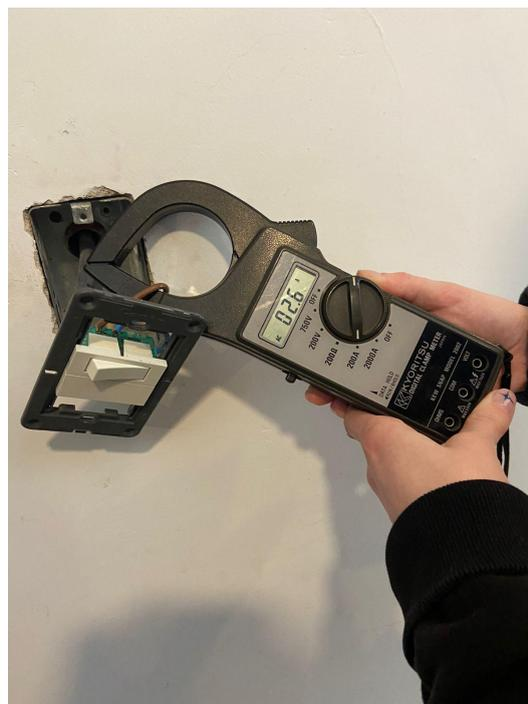
Figura 24. Cableado e instalación de la celda de control en panel de pasillo del segundo piso, medición de corriente de conductor del interruptor de Hall.
