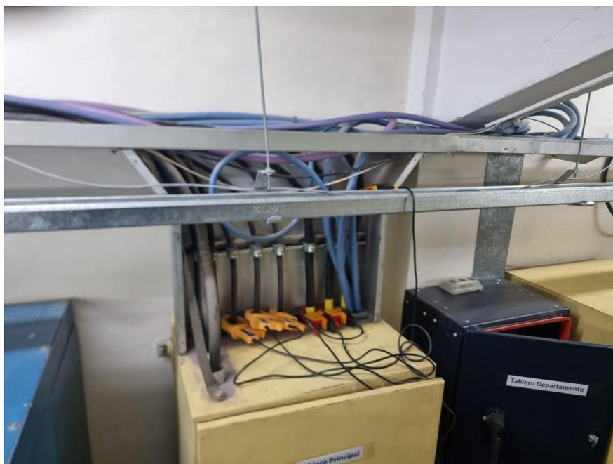
**Figura 20. Equipos HIOKI instalados en los tableros del edificio, vista pinzas de corriente.**
