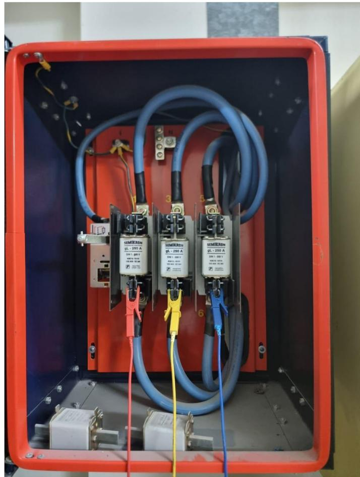
**Figura 20. Equipos HIOKI instalados en los tableros del edificio, vista pinzas de tensión.**
