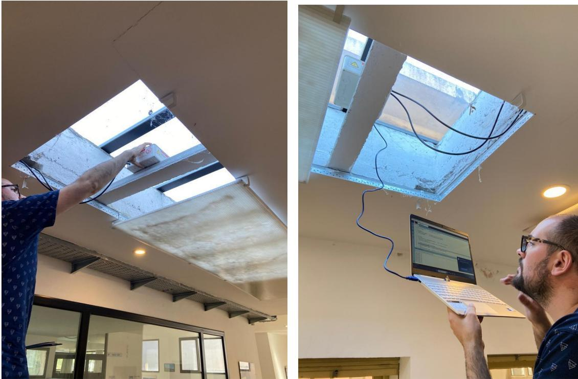
Figura 25 Colocación de celda y control de valores de lux para su programación.
