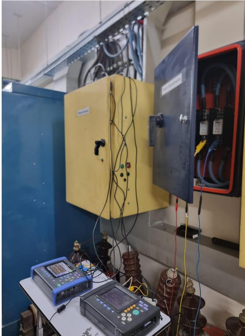
*Figura 19 Equipos HIOKI instalados en los tableros del edificio.*
